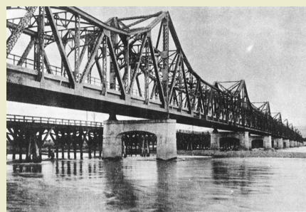
長生橋の鉄橋架け替え工事が完了。奥に見えるのは以前の木橋（昭和12年）
