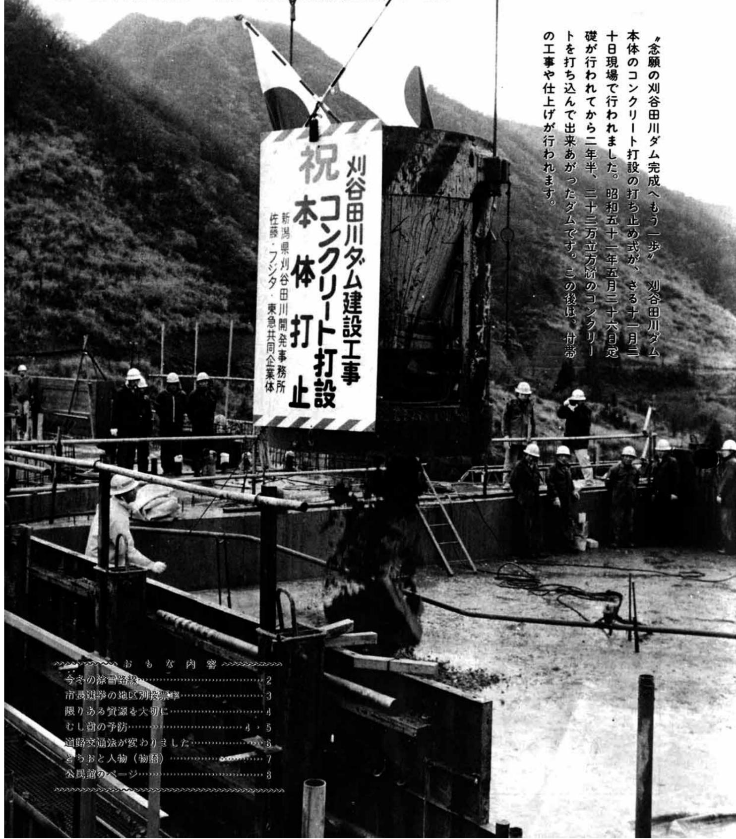
「念願の刈谷田川ダム完成へもう一歩」 刈谷田川ダム本体のコンクリート打設の打ち止め式が、さる十一月二十日現場で行われました。昭和五十一年五月二十六日基礎が行われてから二年半、二十三万立方メートルのコンクリートを打ち込んで出来あがったダムです。この後は、付帯の工事や仕上げが行われます。
