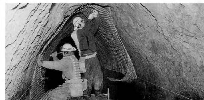
小松倉地区にある、手掘りの中山隧道の保存工事が始まりました。今回の保存工事は、落石等を防止するために行われます。中山隧道の保存工事は、落石等を防止するために行われます。
