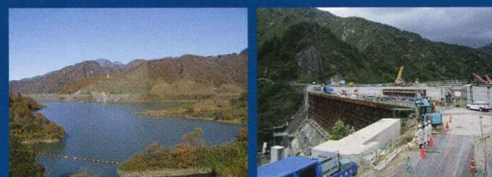
(左) 大谷ダムのダム湖は、旧・下田村の村花であったヒメサユリにちなんで、ひめさゆり湖と名付けられた (右) かさ上げ工事中の笠堀ダム
