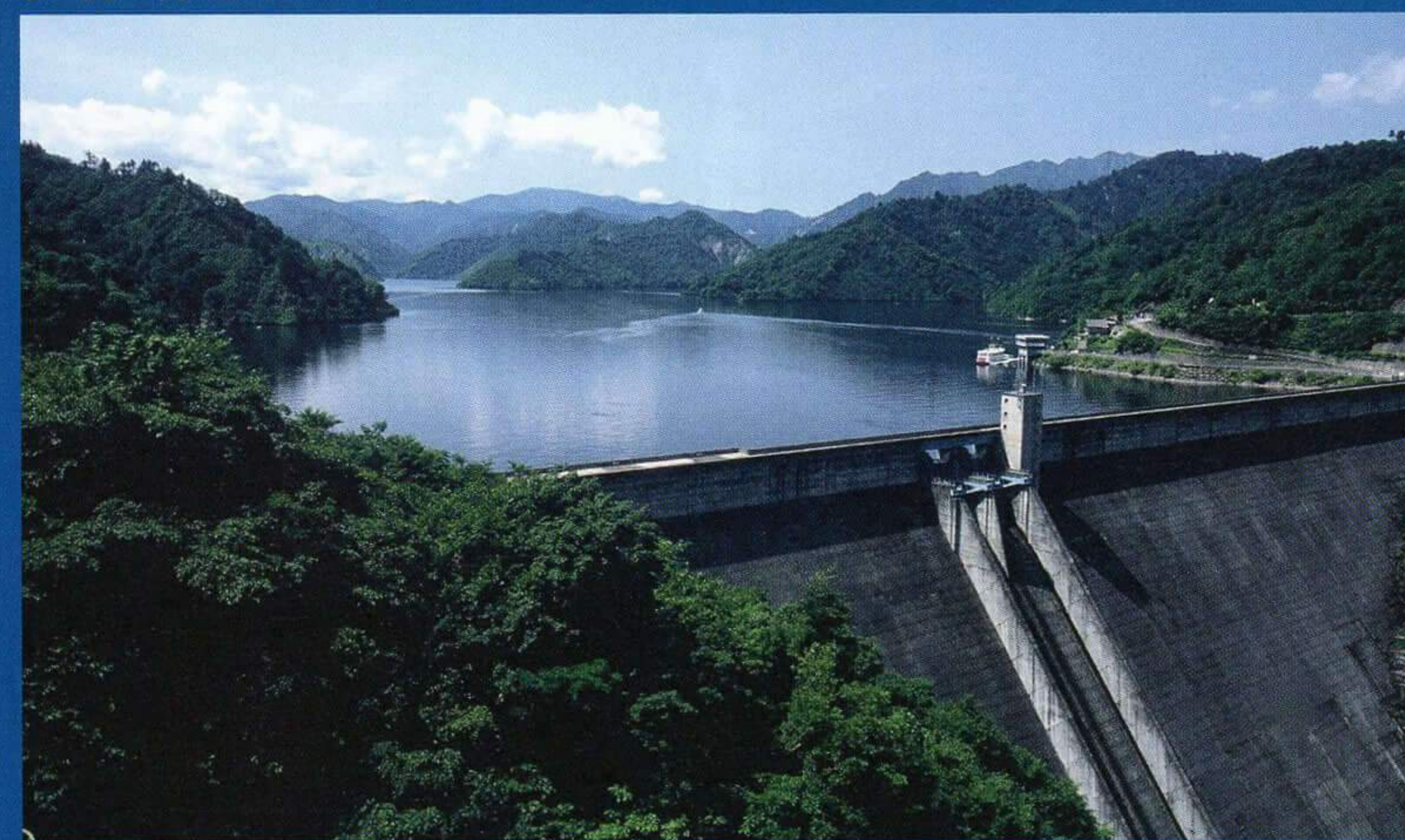
奥只見ダムの巨大なダム湖と堤体
