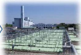
汚水をゆっくり流し、この間に汚泥を底に沈めます。悪臭防止のため池の上はフタで覆っています。(滞留時間1.5～2時間)
