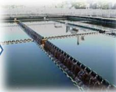
再び水をゆっくり流し、汚れを食べた微生物(活性汚泥)を沈めます。きれいになった上澄水(処理水)を集めます。(滞留時間2～3時間)
