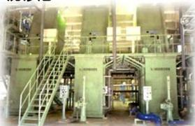
下水道管を流れてきた汚水は流入ゲートを通り、大きなごみと砂を取り除きます。
