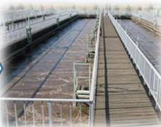
ブロウから空気を送り攪拌します。この間に、微生物(活性汚泥)は水中の有機物を食べ、汚れを分解します。(滞留時間6～8時間)
