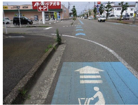
写真 ブルーラインの設置例
