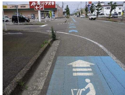
写真 ブルーラインの設置例
