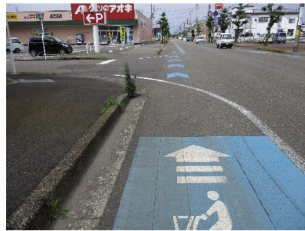
写真 ブルーラインの設置例
