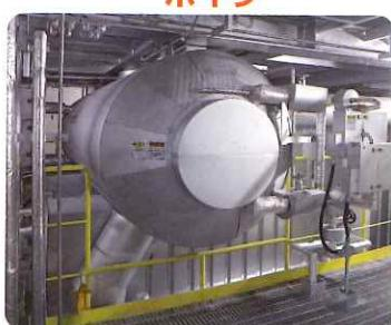
ごみ焼却によって発生する熱はボイラで蒸気として回収します。
