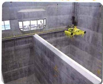
約8日分のごみを貯留できるごみピットに貯留されたごみは、ごみクレーンで搅拌されたあと、焼却炉に運ばれます。
