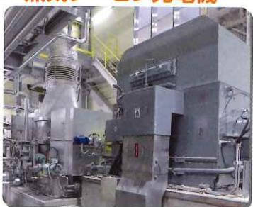
廢熱ボイラで作り出した高温・高圧の蒸気を利用して最大1,910kWの発電することができます。
