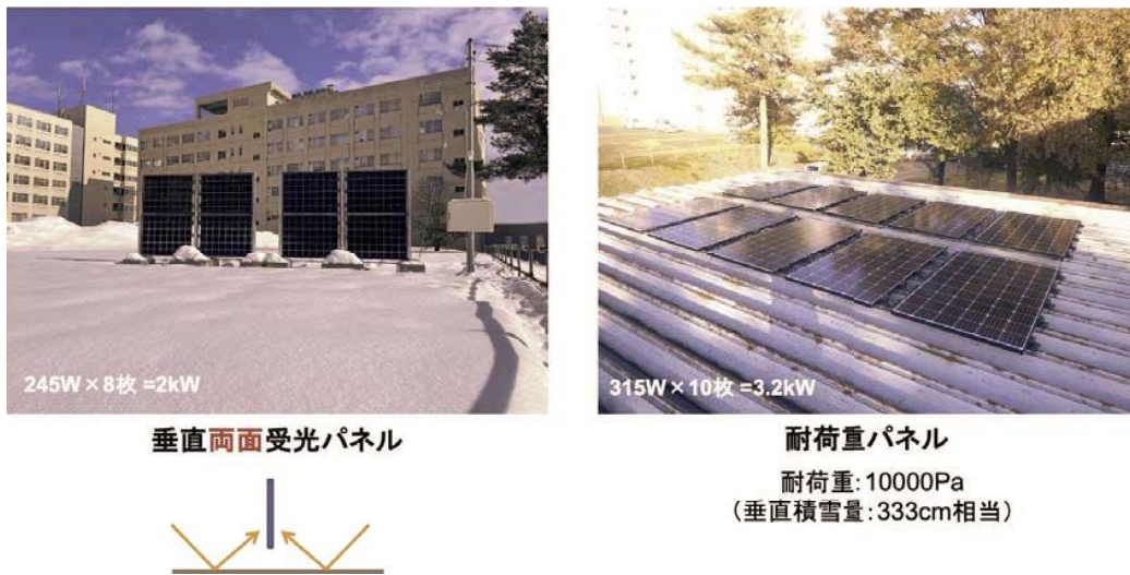
図3 技大に設置した実証実験システム
