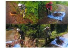
（施設内側溝清掃）
