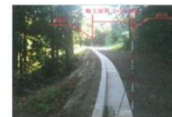
（L型側溝新設）
