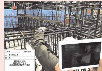
Webカメラを利用した遠隔検査
