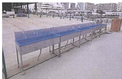
現場の手洗い場所の増設
