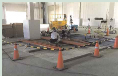
工事エリアの区画を設定して作業
