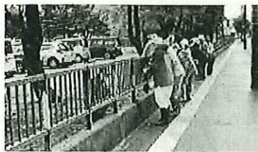
老朽化したフェンスの修繕（地域ボランティアが活動している様子）
