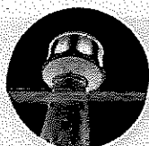
水道タンク (旧中島浄水場配水塔)
