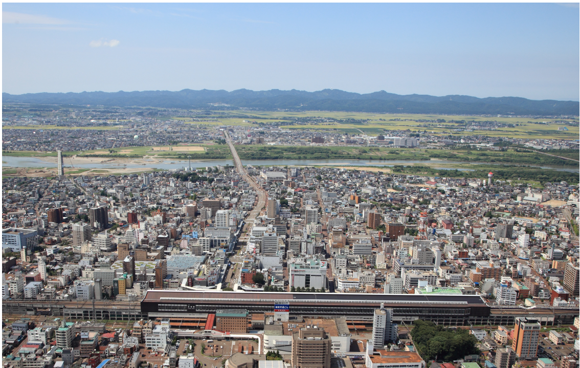
長岡市の中心市街地（手前がJR長岡駅、その奥に西山連峰を望む。）
