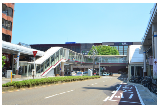
ＪＲ長岡駅と中心市街地を結ぶ「大手スカイデッキ」
