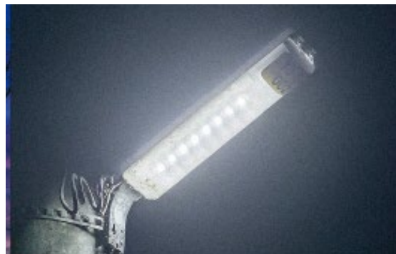
写真 LED 公衆街路灯
