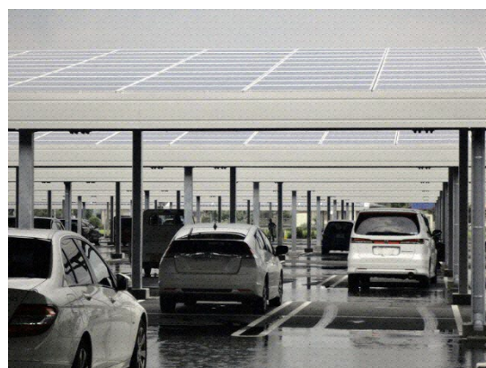
写真 ソーラーカーポートの例
