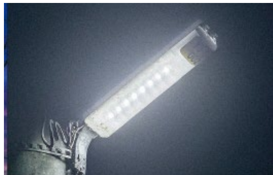
写真 LED 公衆街路灯
