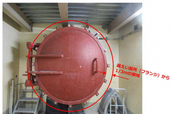
可燃限界濃度を越える可能性がある領域 (S/C出入口ハッチ)
