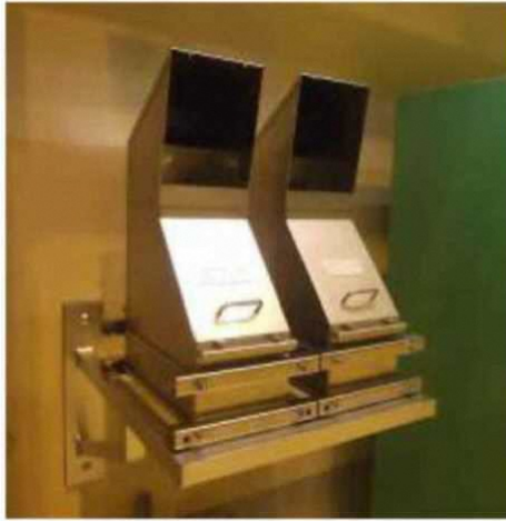
静的触媒式水素再結合装置 (PAR)
