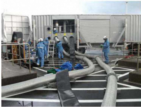
熱交換器ユニット及び大容量送水車作業
