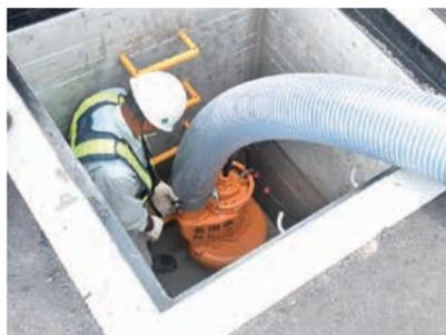
昨年の台風で浸水被害が発生した今井地区では、雨水管に接続した集水ますに可搬式ポンプを常設化。ポンプの口径は200mmで、1分間に4トンの水を排出することができます。緊急時に迅速な排水作業を行うことで、浸水被害の軽減につながります。
