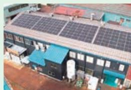
▲工場の屋根に設置した太陽光パネル。遮熱効果で空調効率も改善します
