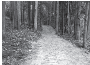
▲森林環境譲与税を活用して整備した作業道
