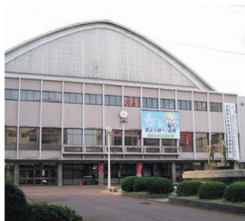
～長岡市厚生会館～
