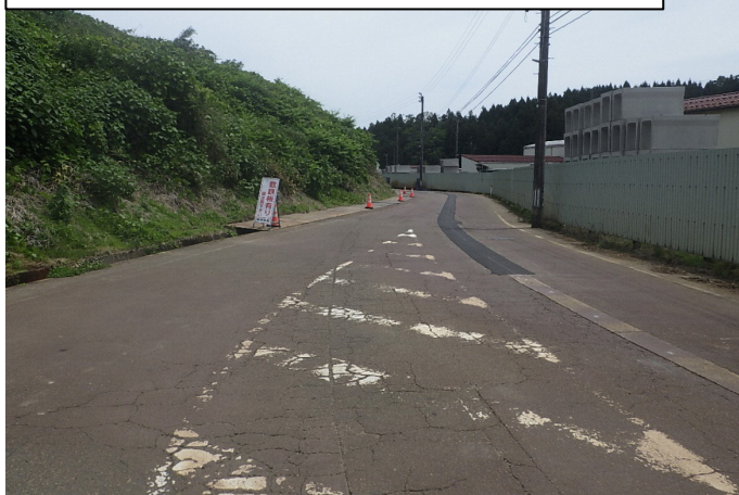
A01-021 与板171号線ほか(舗装修繕)
