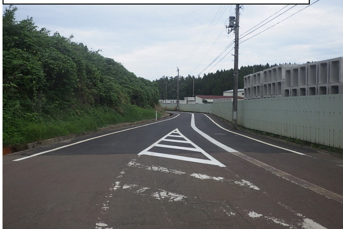
A01-021 与板171号線ほか(舗装修繕)
