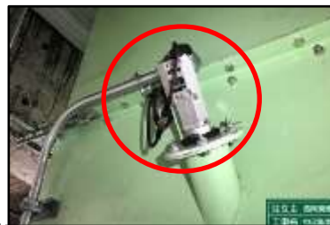
炎検知器を2台追加 ベルトコンベアの裏側に配置（監視強化）
