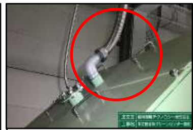
散水配管を4カ所追加 消火栓から延長放水管を設置（拡大防止強化）
