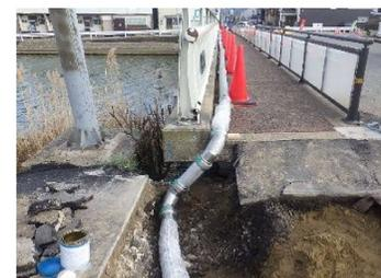
(迅速な判断による仮設配管の設置)
