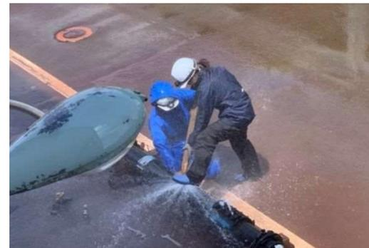
【模擬水道管を使った止水訓練】
