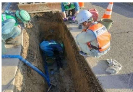
【応急復旧の様子】
