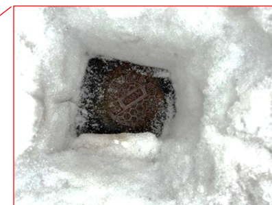
〈雪山の中から直径20 c m程度の 仕切弁をピンポイントで発見〉
